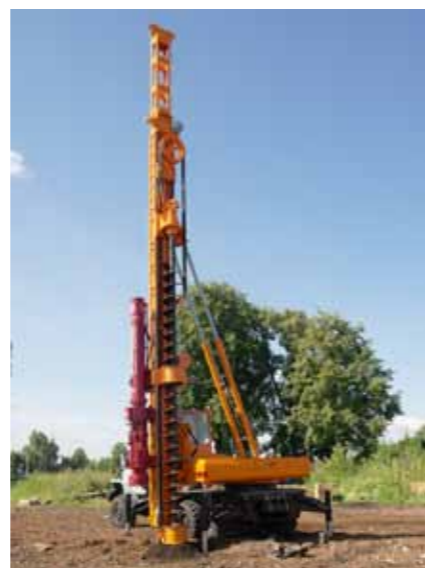
Бурение скважины на BM-811M
