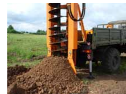
Бурение скважины на МБШ-519
