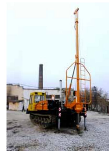
Бурение скважины на БКМ-534А
