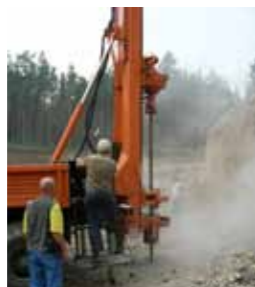
Бурение с пневмоударником
