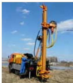
Бурение скважины на УРБ-51
