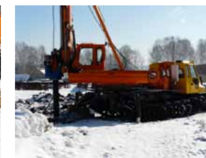
Бурение скважины с поворотом платформы на БКМ-2032
