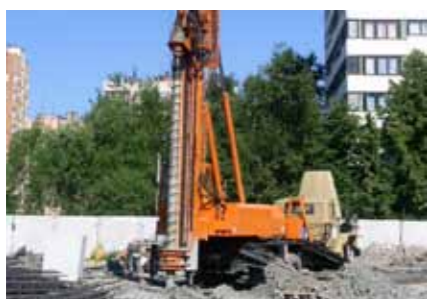
Бурение скважины на МБШ-818
