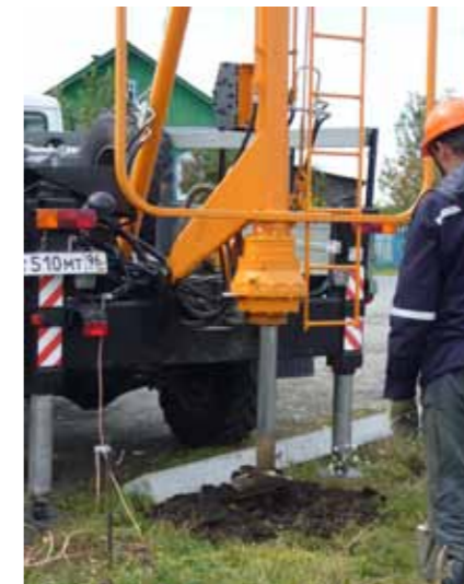
Бурение скважины на БКМ-317А-01
