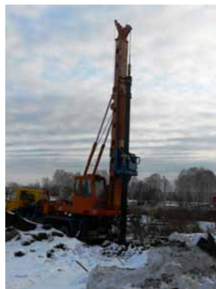
Бурение скважины на БКМ-2012
