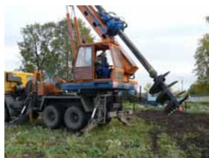
Подготовка к бурению под углом к поверхности
