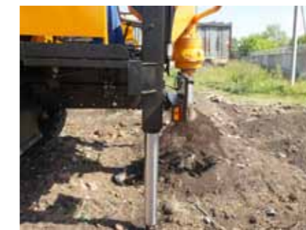
Разброс грунта при бурении на БКМ-516
