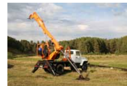
Бурение скважины на МРСК-311 с поворотом платформы
