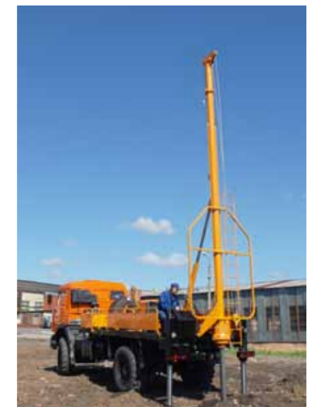
Бурение скважины на БКМ-516
