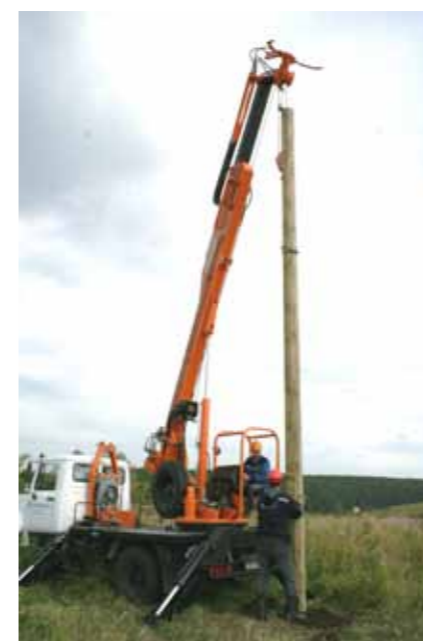
Установка опоры ЛЭП
