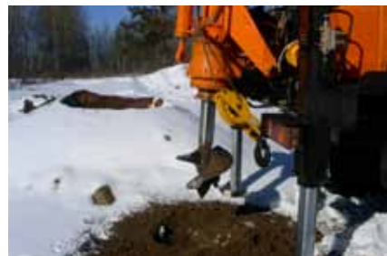
Бурение скважины на БКМ-515
