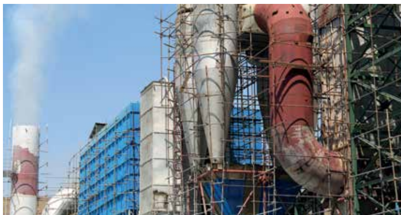
В 2011 году в провинции был введен в эксплуатацию новый металлургический завод
