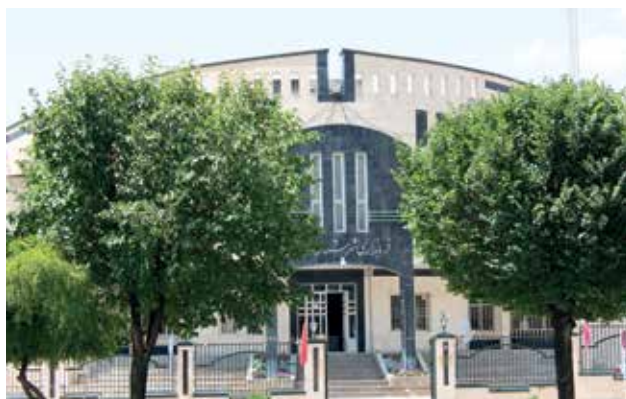
Здание администрации шахрестана Нехаванд
